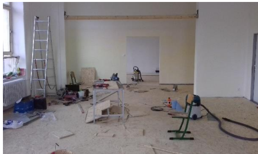
Demontáž původní podlahy
