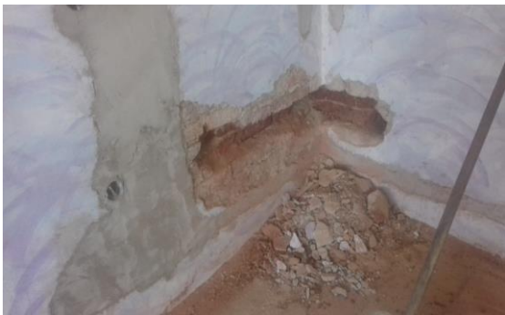
Nové rozvody vody v kanceláři
