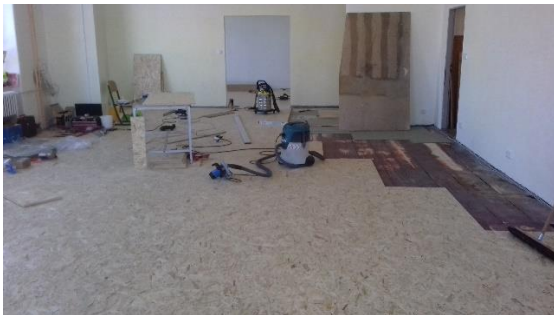
Pokládání nové podlahové krytiny ve dvou vrstvách
