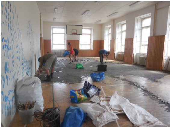
Rozebírání původní podlahy
