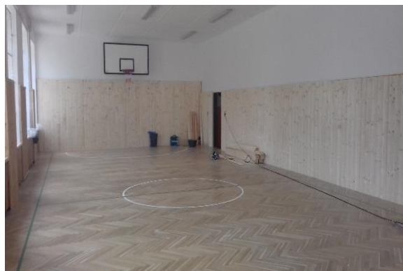
Nová část obložení
